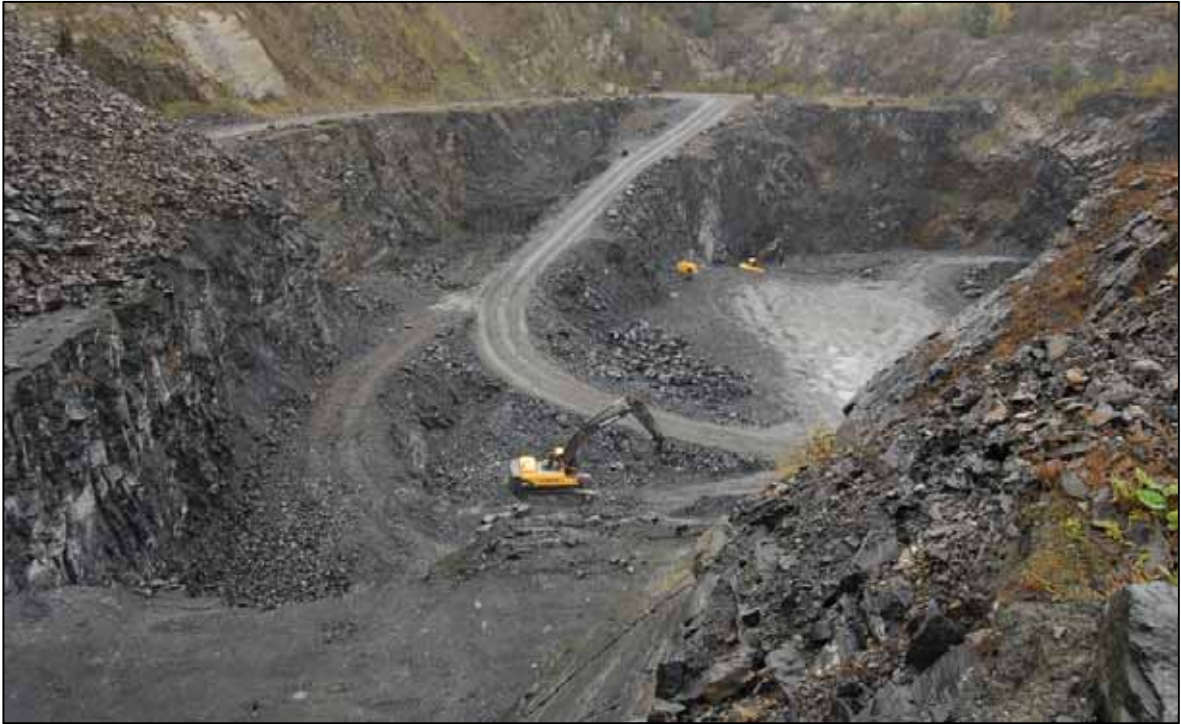
De carrière de la Flèche gezien vanuit het oosten van niveau -1, met zicht op niveau -3, en het recente niveau -4 op de achtergrond (situatie 11/10/2011). Deze foto illustreert de talloze breuken onder invloed van het Hercynisch metamorfisme bij condities van lage druk en matige temperatuur. Het voorkomen van zeolieten, met prehniet en pumpellyiet-(Al) in deze breuken wordt verklaard door een traag continu afkoelingstraject (Hatert en Theye, 2005). Foto © Alain Hanson.
